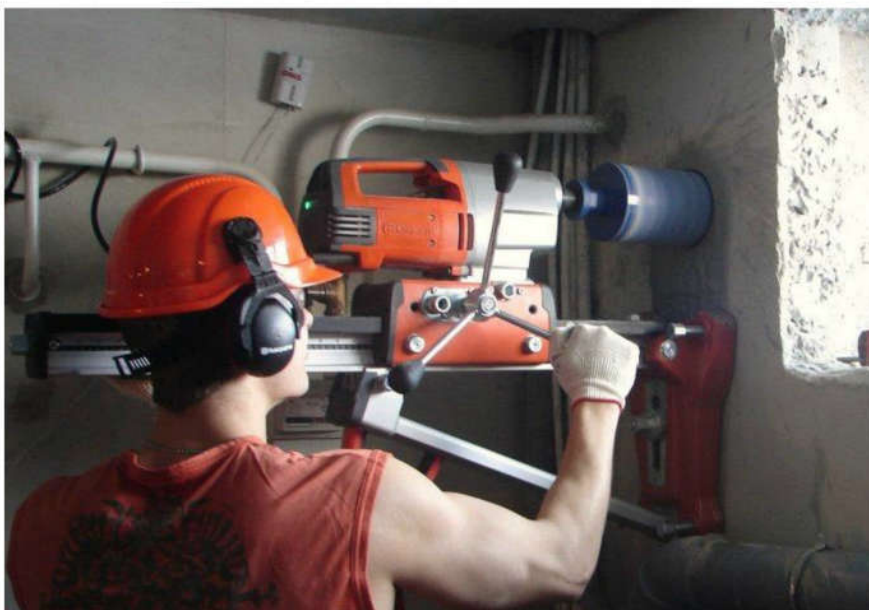
Рис. 3. Кернаотборник, установленный для отбора пробы в стене здания
