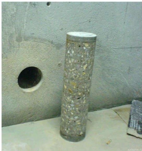
Рис. 4. Керновый образец, отобранный из бетонной оштукатуренной стены (по краям керна наблюдаются слои штукатурки)
